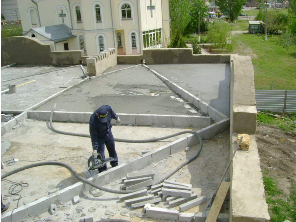
Разуклонка легким бетоном
