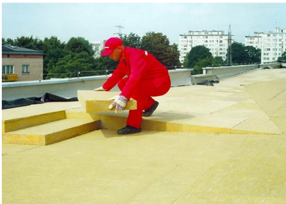
Разуклонка клиновидными плитами
